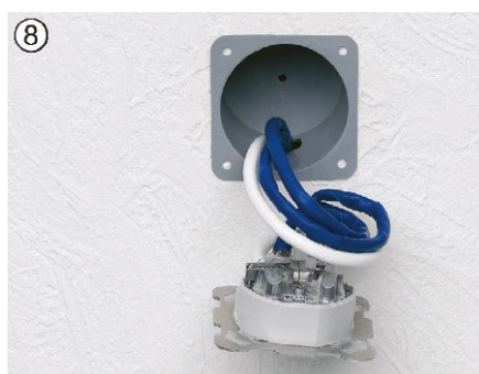
⑧ Enrouler la réserve de câble et installer la prise.
